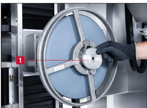
**Bild 7-65** Klemmflansch aufsetzen
