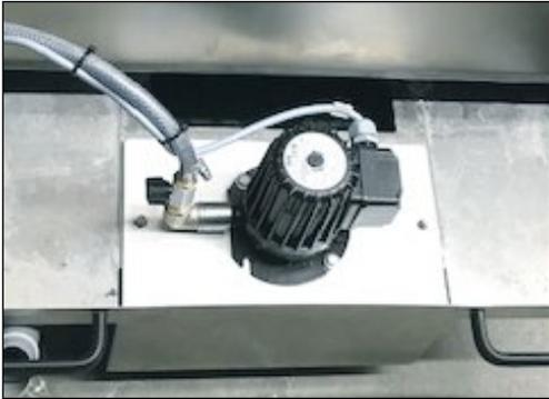
Imagen 7-33 Cambio del agua de refrigeración
