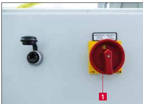
**Figure 3-5** Interrupteur principal
