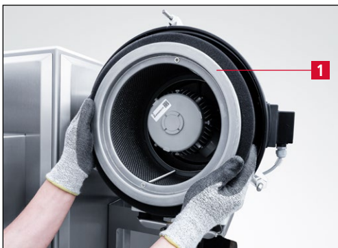
Imagen 8-5 Extracción del filtro
