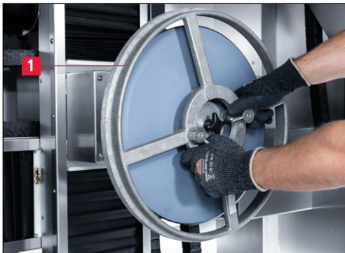
Figure 7-49 Retrait de la protection du couteau
