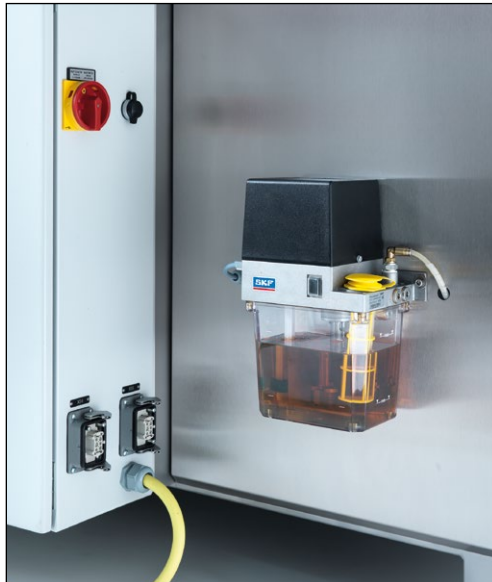
Bild 9-7 Zentralschmierung
